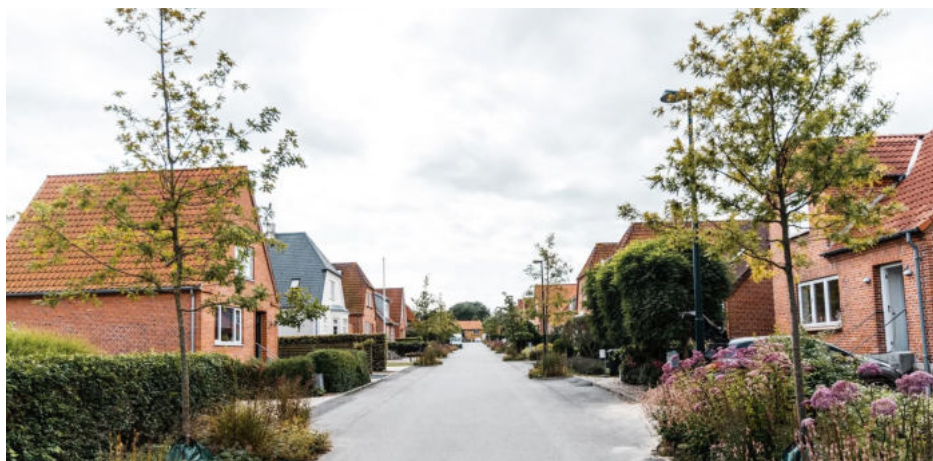
Eksempel: Regnbed på en villavej i Middelfart
